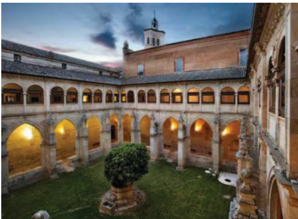
Vista del claustro
